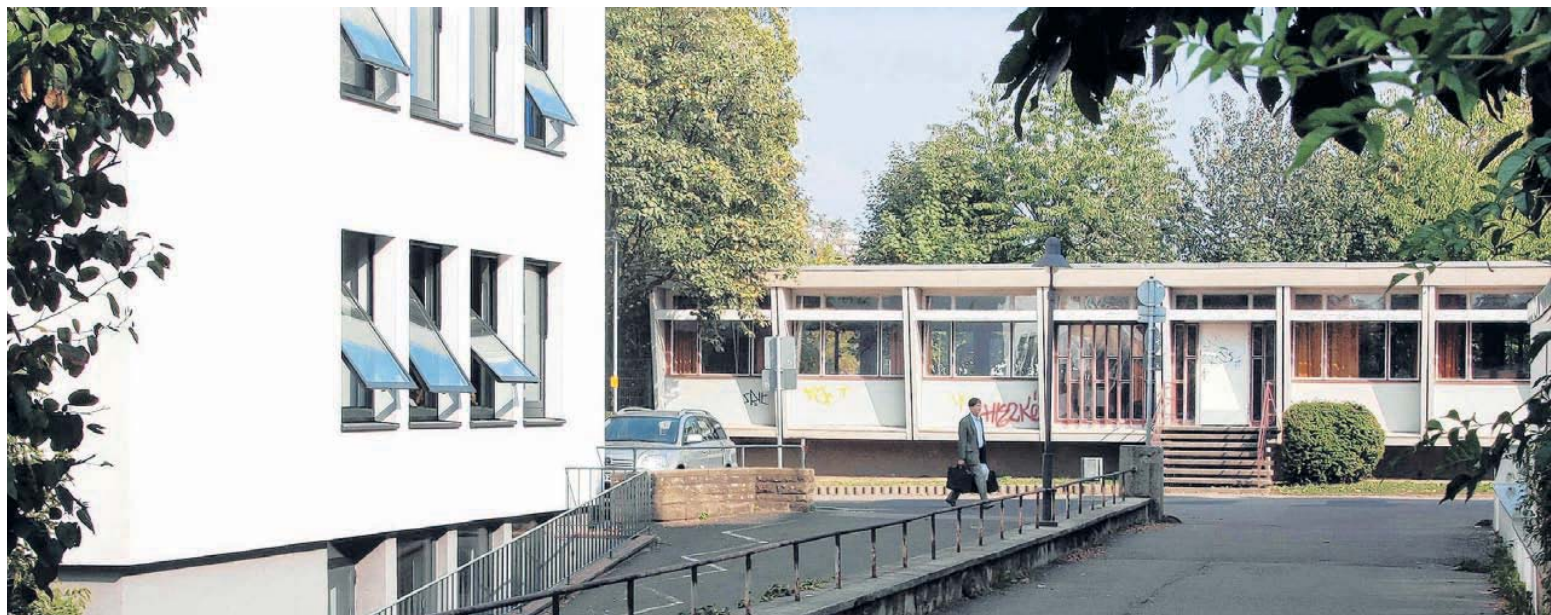
Teile des Mönchsee-Gymnasiums wurden bereits saniert. Nun ist eine Aufstockung geplant, wodurch der Pavillon (hinten) überflüssig wird.
